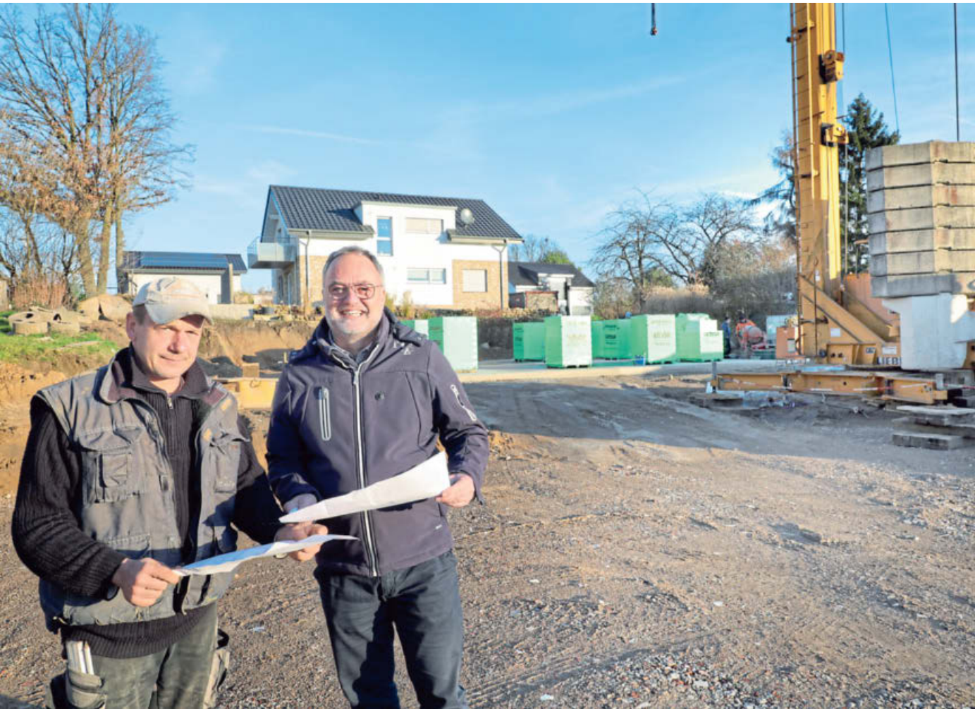
Polier Tobias Knoll und Investor Olaf Schweneker freuen sich über gutes Wetter auf der Baustelle.
