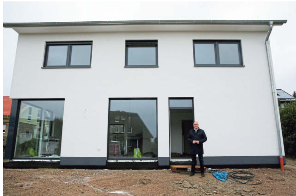
Große Fensterfronten: Bevor Architekt Ralf Heuter das moderne Einfamilienhaus im Kroneweg 1 an die Eigentümer übergibt, kann es am Sonntag besichtigt werden.
