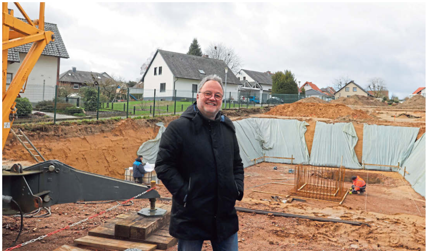
Olaf Schwenecker vor der Baugrube. Dort wird das Mehrfamilienhaus mit sechs Wohneinheiten entstehen.
