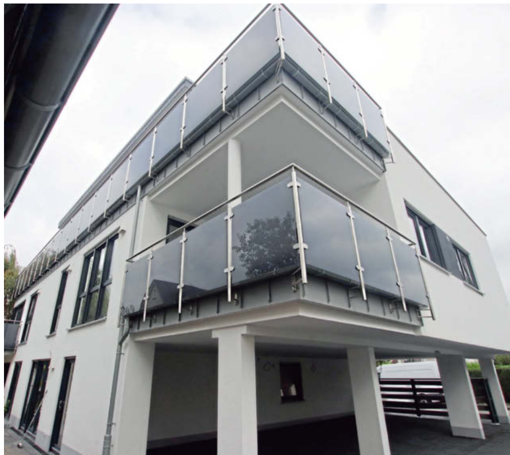
Jede Wohnung im Haus an der Bülowstraße 14 hat einen großen Balkon oder eine Terrasse nach hinten zum Garten. Bodentiefe Fenster lassen zudem viel Licht in die Wohnung.
