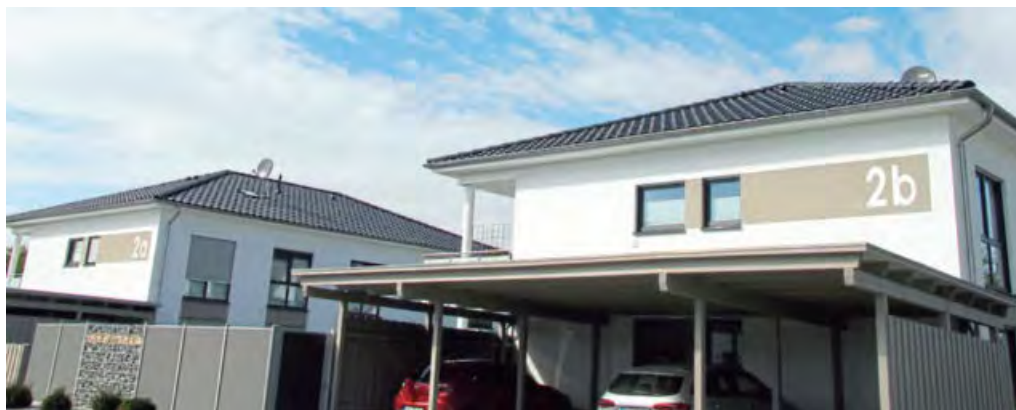
In Rehme: An der Korbmacherstraße hat die Firma Schweneker bereits mehrere Häuser gebaut, darunter auch diese Mehrfamilienhäuser, in denen vier Parteien wohnen.
