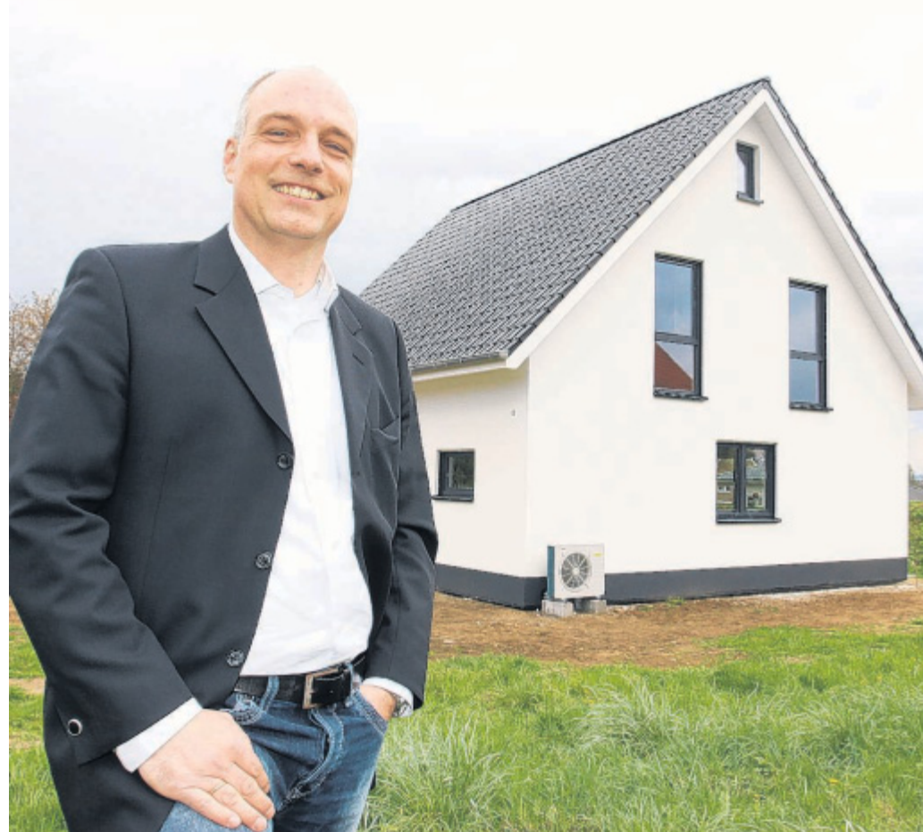
Für eine Familie: Architekt Ralf Heuter vor dem Einfamilienhaus in Volmerdingsen. Ein Wärme-Tauscher an der Außenfassade sorgt drinnen für energieeffizientes Heizen.
