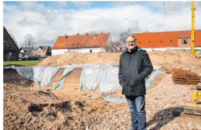
Auf der Baustelle an der Wiesenstraße: Geschäftsführer Olaf Schweneker.
