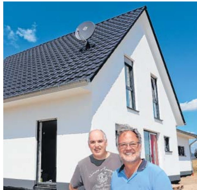
Vor dem Neubau: Olaf Schweneker (r.) mit Bauherr Bernd Kreisler.
