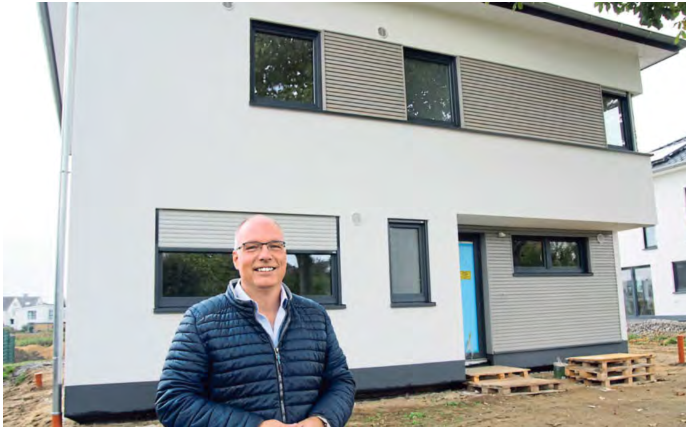
Vor der Stadtvilla in Ostscheid: Architekt und Diplom-Ingenieur Ralf Heuter hat das Haus individuell nach den Wünschen der Bauherren entworfen und gestaltet.
