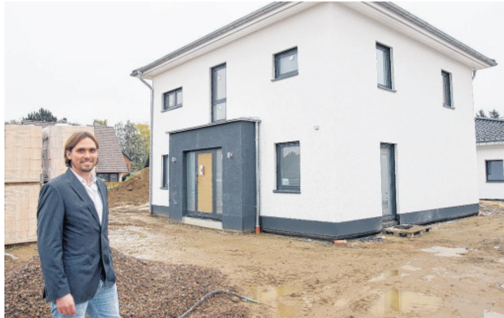
Referenz-Objekt Stadtvilla in Elverdissen: Fabian Birk, Diplom-Ingenieur und Projektmanager Bau bei Schweneker Massivhaus, freut sich auf Besuch interessierter zukünftiger Bauherren. FOTOS: KIEL-STEINKAMP
