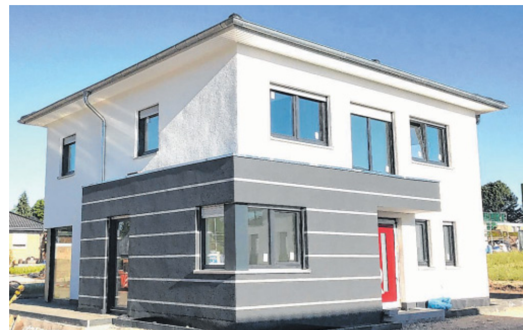
Schulgarten 22: Großflächige Fensterflächen sorgen für eine helle Atmosphäre FOTO: SCHWENEKER
