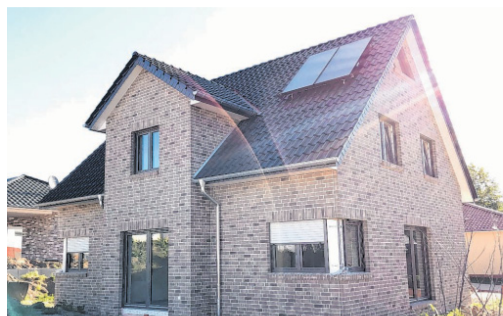
Klassisch: Das moderne Einfamilienhaus mit Klinker und Satteldach am Schulgarten 9. FOTO: SCHWENEKER
