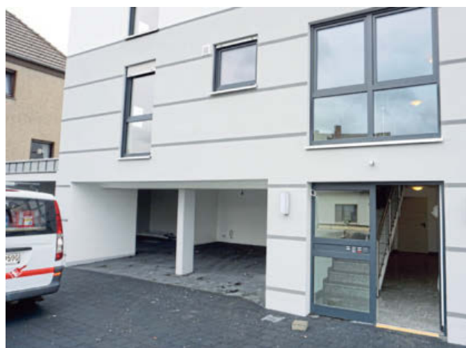
Augenfällig: Die Stellplätze im Mehrfamilienhaus befinden sich direkt im Haus.
